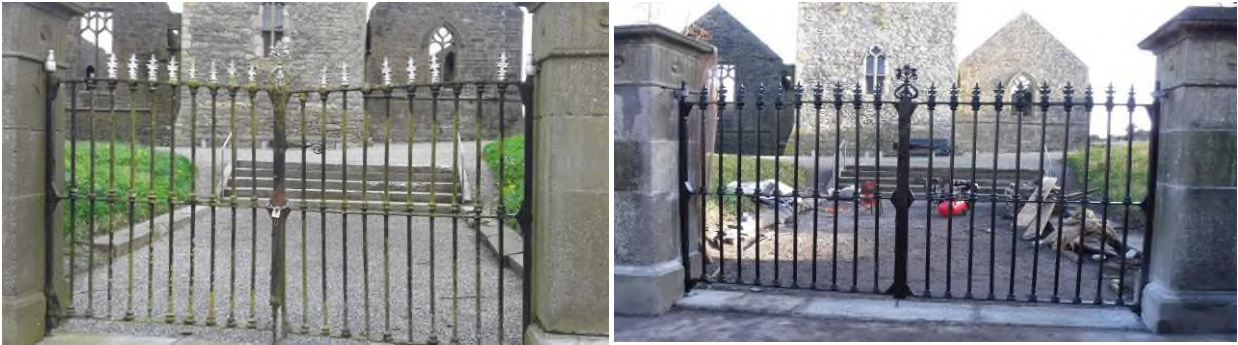
Íomhánna roimh thosú na n-oibreacha ar geataí iarainn bhualte 19ú haois agus tar éis na n-oibreacha sin. Eaglais Mhuire, Callainn.
