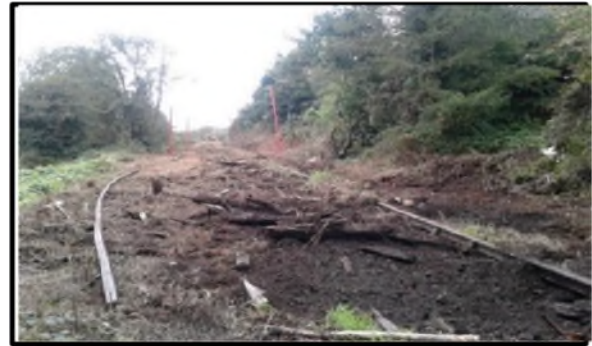
Seanráillí agus sean trasnán a ardú feadh bhealach Ghlasbhealach an Oirdheiscirt
